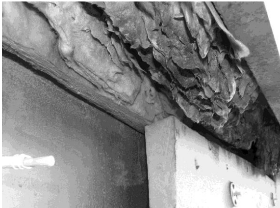
Obr. 7: Růst řas na tepelné izolaci
