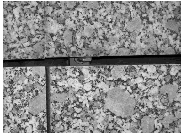
Obr. 8: Proměnlivá šířka spár mezi deskami
