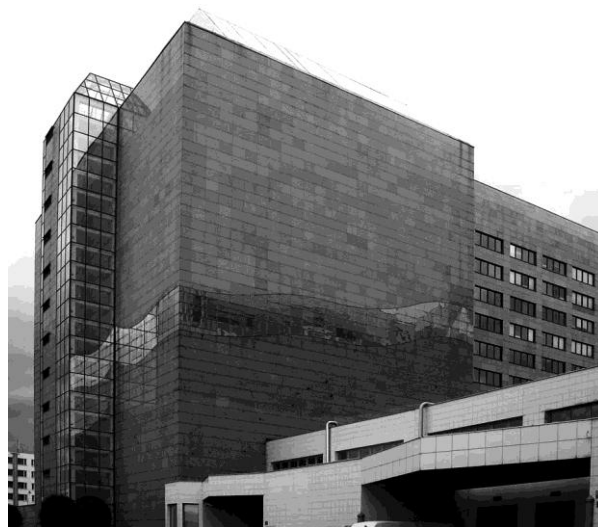
Obr. 1: Depozitář archivu hlavního města Prahy
