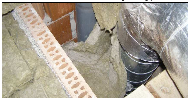
Obr. 5 – Neutěsněné technické prostupy
