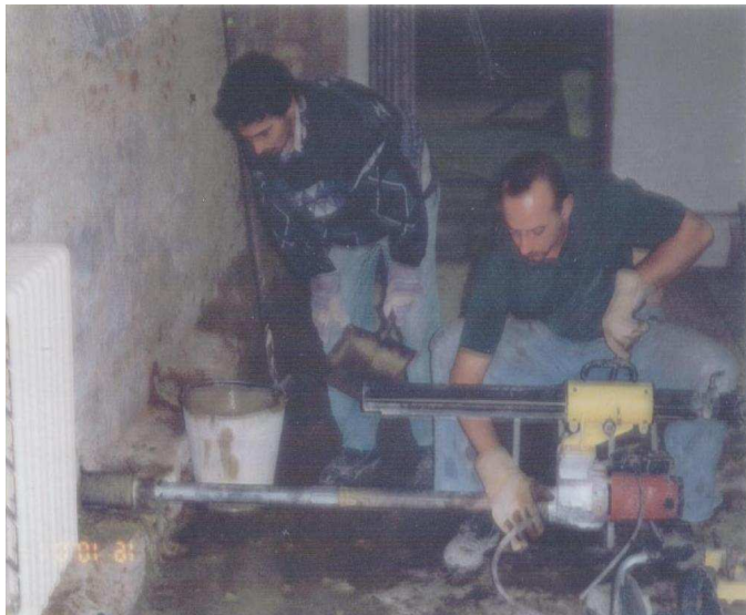
Obr. 7: Vývody příčného plastového potrubí do interiéru
