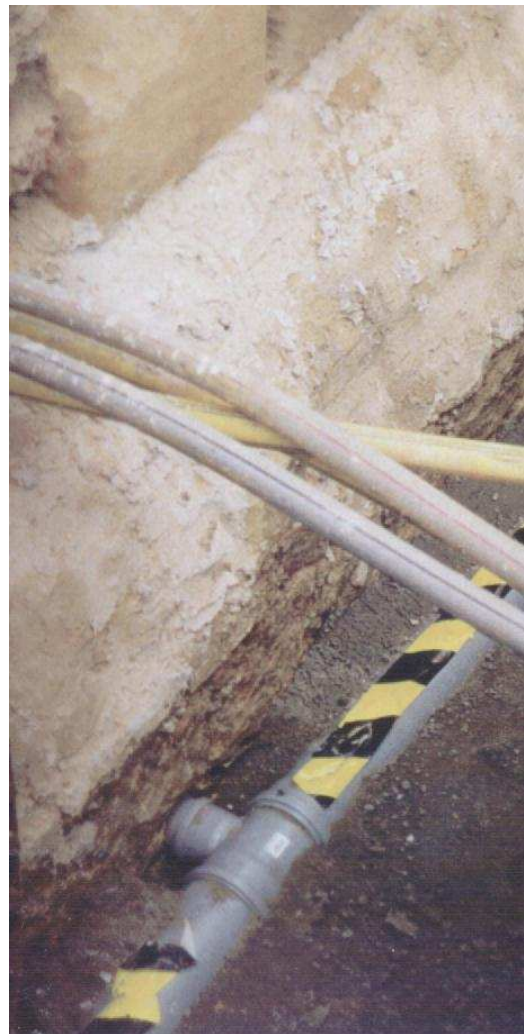
Obr.6: Kolmé napojení příčných otvorů do sběrného potrubí před zakrytím nopovanou fólií (žlutočerná páska má funkci dočasné ochrany před zanesením zeminou)
