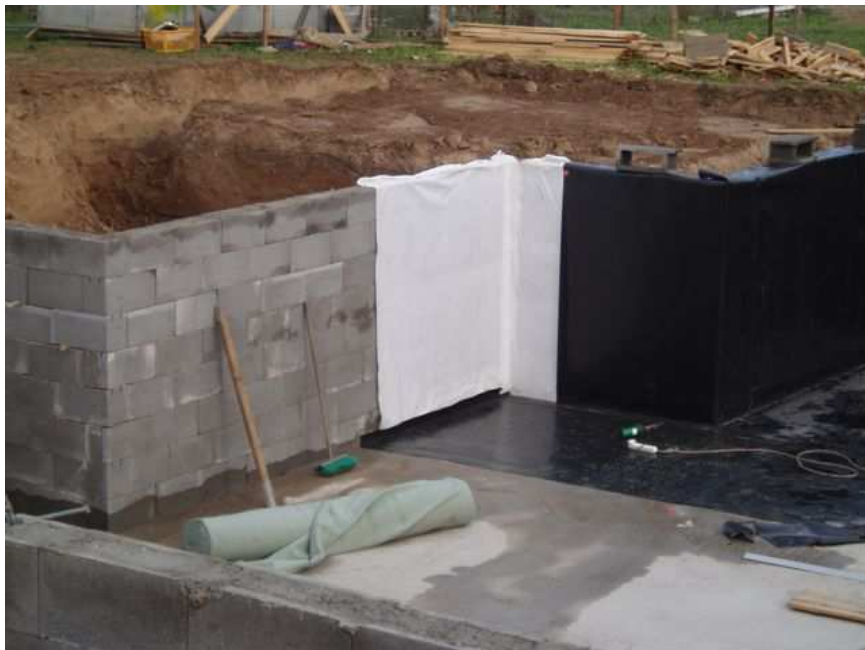
Obr. 3: Montáž hydroizolační fólie z PVC-P na nosný plášť z bet. tvarovek
