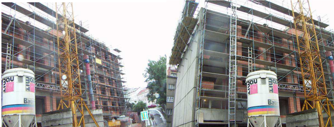
Obr. 25 a 26 Rekonstrukce objektů komplexu Nad Bohemkou.
