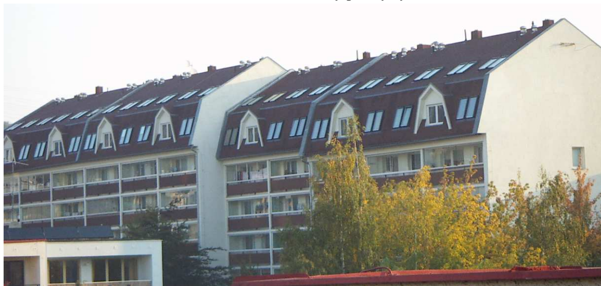
Obr. 24 Pohled na realizovanou nástavbu – stěnový příčný systém.
