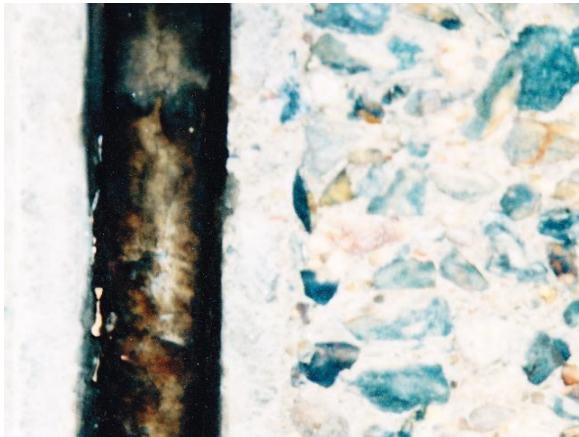
Obr. 7: Boční lemující hrany nasáklé vlhkostí po předchozím dešti
