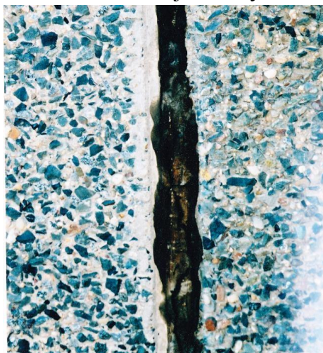
Obr. 7: Boční lemující hrany nasáklé vlhkostí po předchozím dešti
