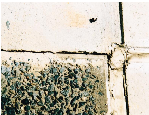
Obr. 2: Pronikání vody do vnitřní pěnové výplně svislé spáry chybějícím tmelem
