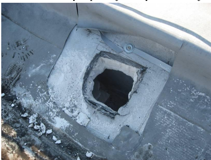
Obr. 6: Sonda v styku plochej strechy a obvodovej steny
