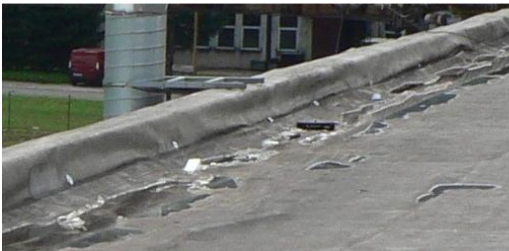
Obr. 4: Kotvy příliš blízko okraje, navíc přetažené
