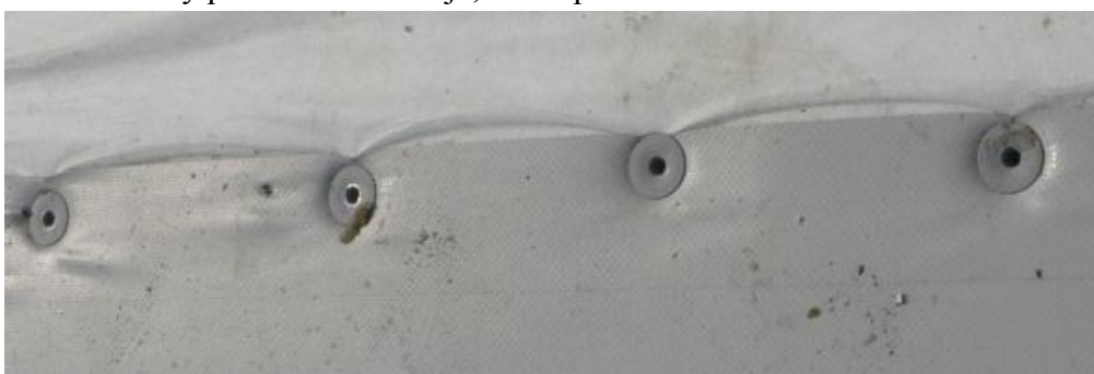
Obr. 4: Kotvy příliš blízko okraje, navíc přetažené
